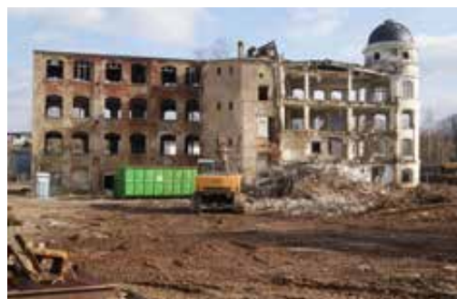
Abbruch der LISEMA-Gebäude, 2017 Foto: Dr. Reinhard Jeromin
