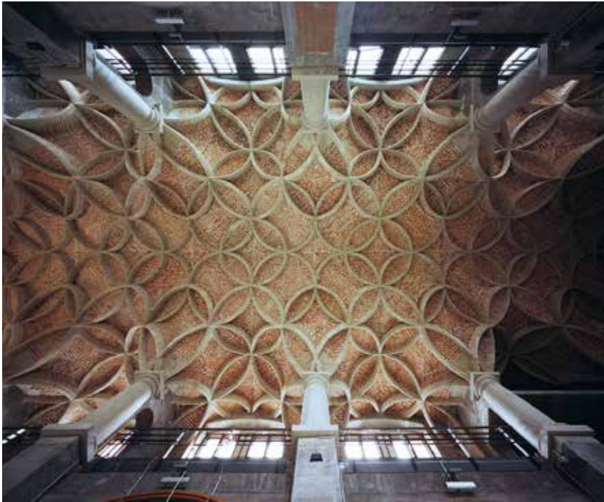
Residenzschloss Dresden, Schlosskapelle, Gewölbeunter- sicht des wiederaufgebauten Schlingrippengewölbes Foto: Rainer Böhme
