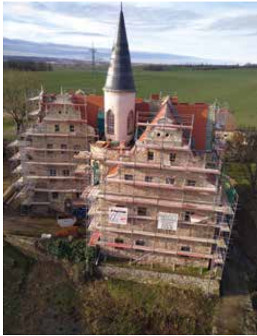
Schloss Oberau im Bau Foto: Gemeindeverwaltung Niederau
