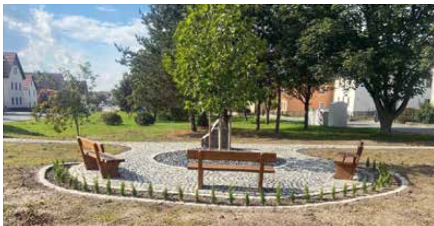
Pflasterarbeiten in der Dorfmitte Quersa Foto: Gemeinde Lampertswalde
