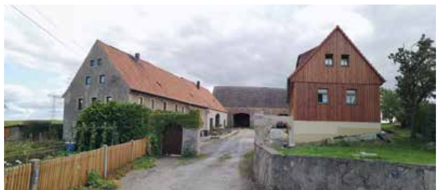
Errichtung eines Ersatzneubaus in ursprünglicher Anmutung unter Verwendung traditioneller Materialien und Einhaltung aktueller Anforderungen an modernes und nachhaltiges Wohnen Foto: Markus Thieme, LfULG
