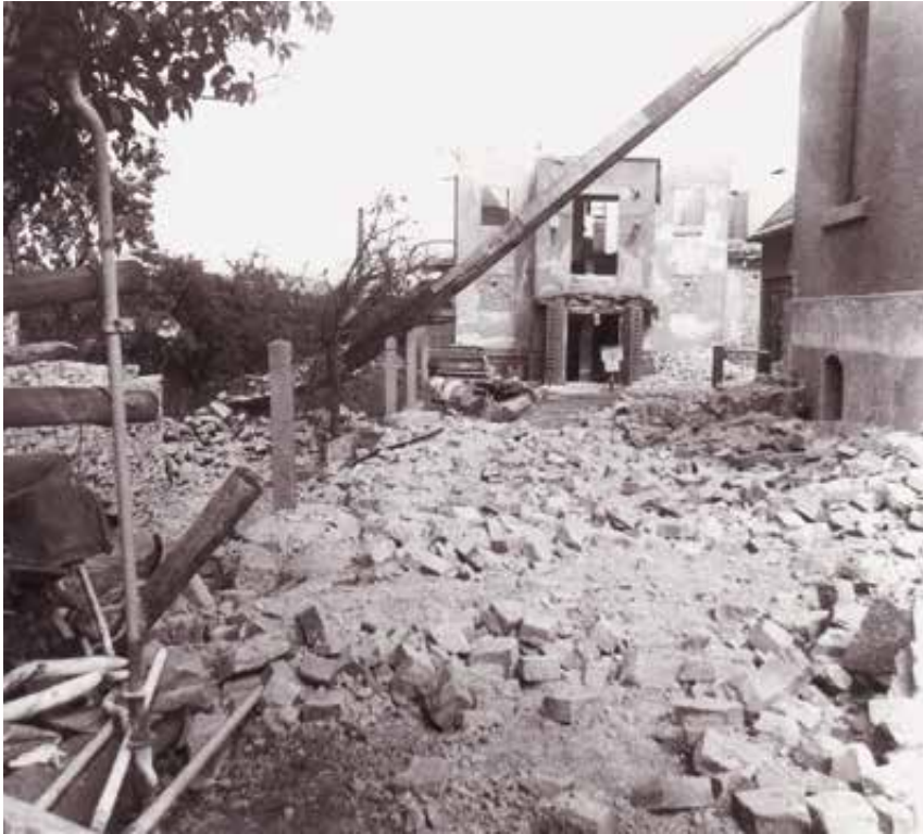
Abbruch des Kurviertels in Oberschlema, 1953 Archiv Oliver Titzmann
